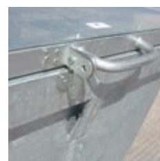
Detail gravitačného zámku
